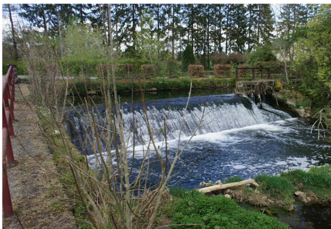
Foto gegen Fließrichtung
