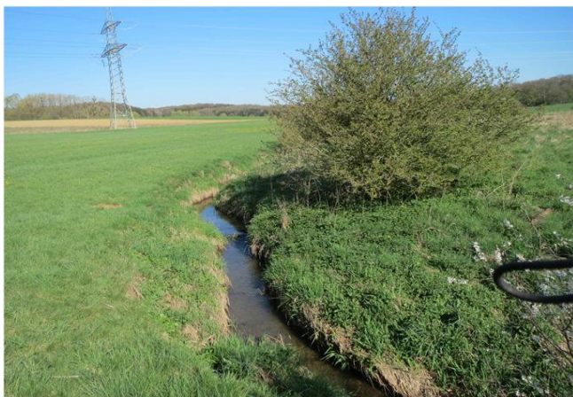
Foto gegen Fließrichtung
