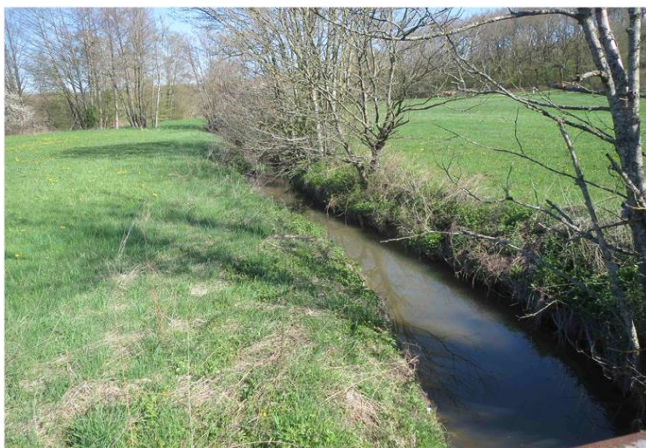
Foto gegen Fließrichtung
