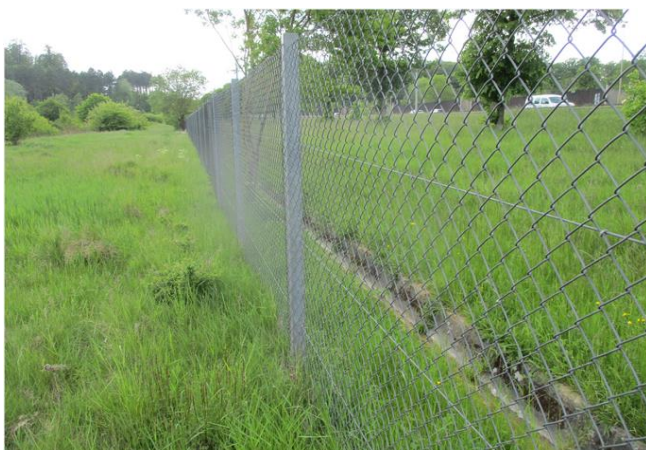
Foto gegen Fließrichtung
