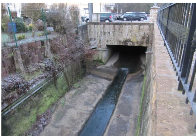
Foto gegen Fließrichtung
