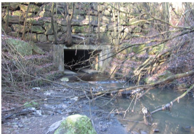
Foto gegen Fließrichtung
