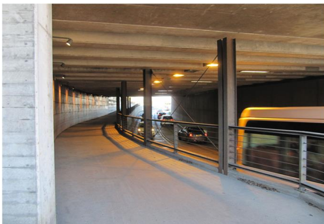
Foto gegen Fließrichtung
