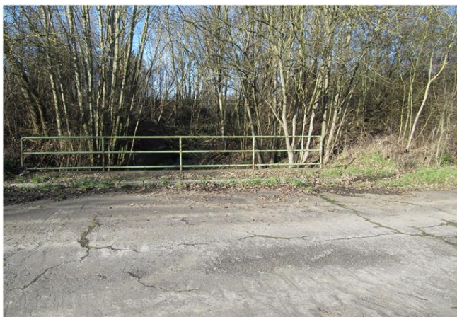
Foto gegen Fließrichtung
