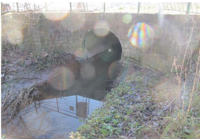
Foto gegen Fließrichtung
