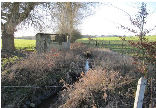
Foto gegen Fließrichtung
