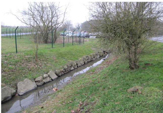
Foto gegen Fließrichtung
