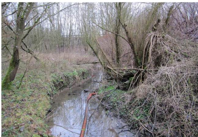
Foto gegen Fließrichtung
