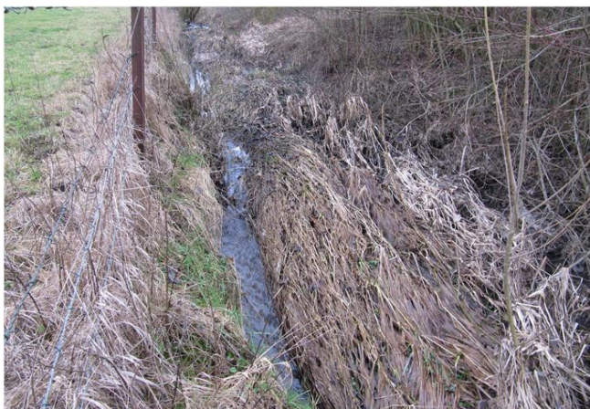
Foto gegen Fließrichtung
