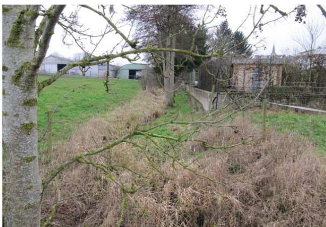
Foto gegen Fließrichtung
