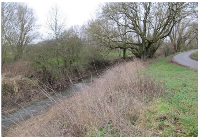
Foto gegen Fließrichtung
