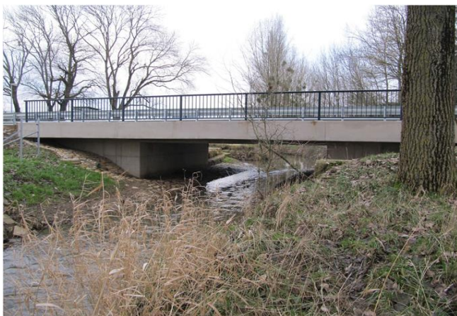
Foto gegen Fließrichtung
