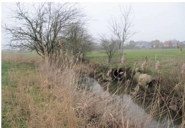
Foto gegen Fließrichtung
