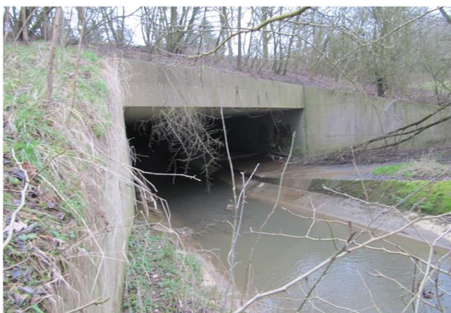
Foto gegen Fließrichtung
