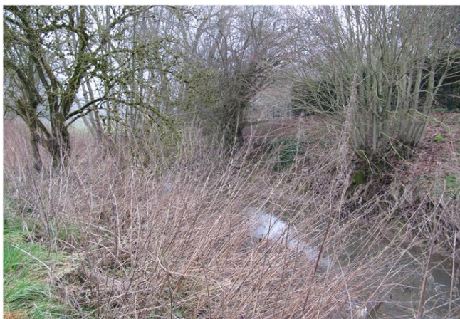
Foto gegen Fließrichtung
