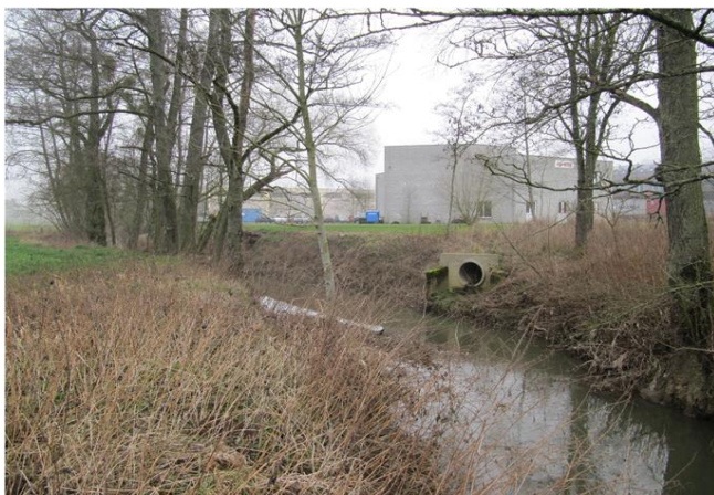
Foto gegen Fließrichtung
