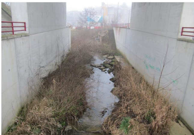
Foto gegen Fließrichtung
