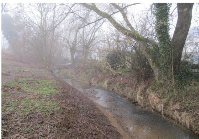
Foto gegen Fließrichtung
