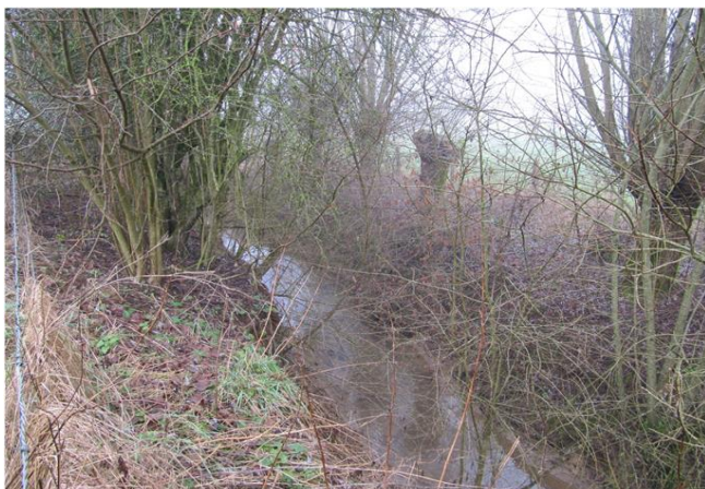
Foto gegen Fließrichtung
