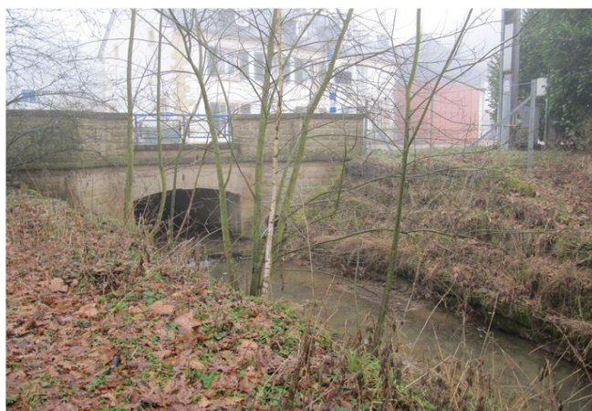
Foto gegen Fließrichtung
