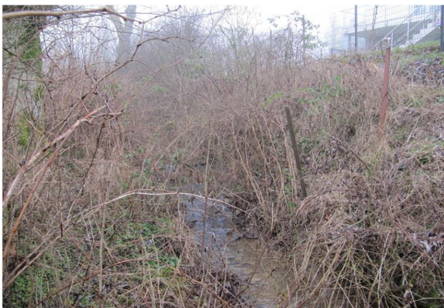
Foto gegen Fließrichtung
