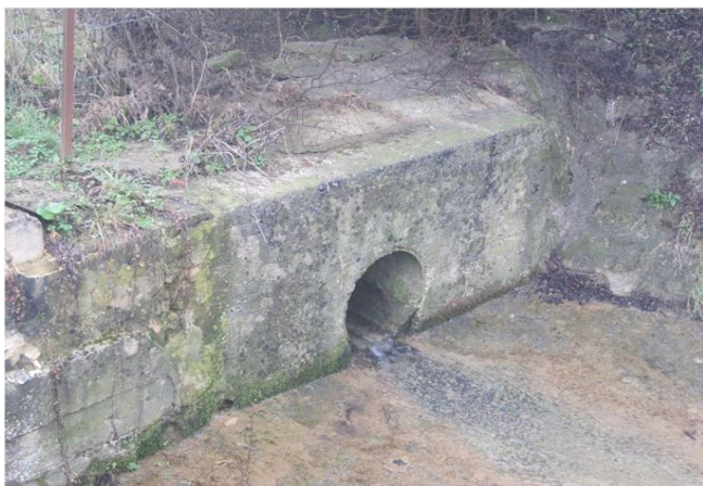
Foto gegen Fließrichtung
