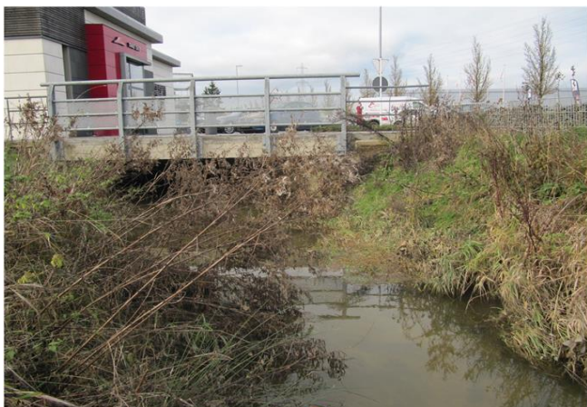
Foto gegen Fließrichtung
