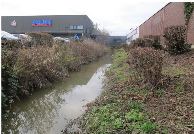
Foto gegen Fließrichtung
