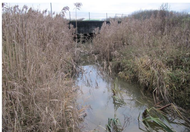
Foto gegen Fließrichtung
