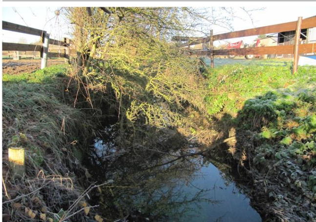
Foto gegen Fließrichtung
