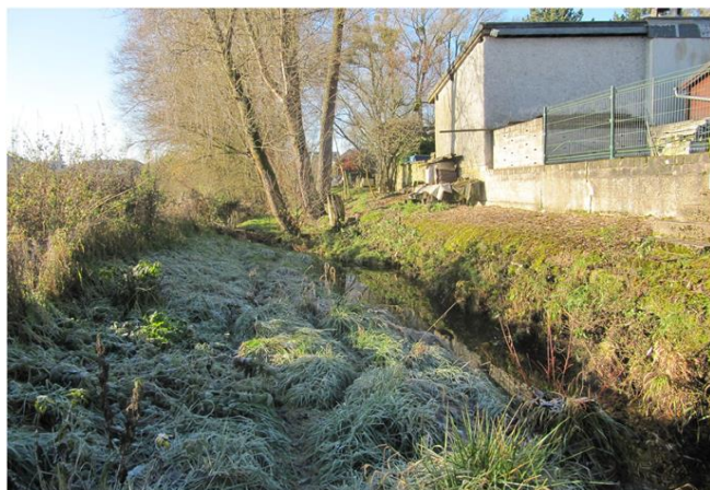
Foto gegen Fließrichtung
