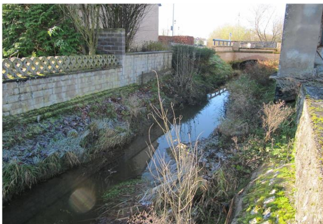
Foto gegen Fließrichtung
