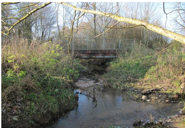
Foto gegen Fließrichtung
