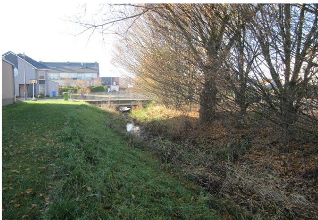
Foto gegen Fließrichtung
