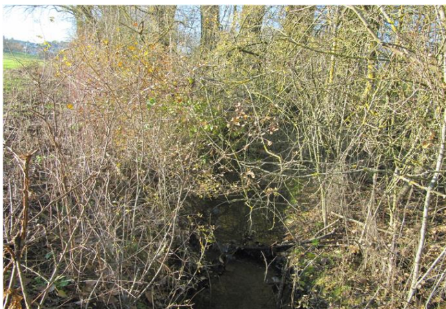
Foto gegen Fließrichtung
