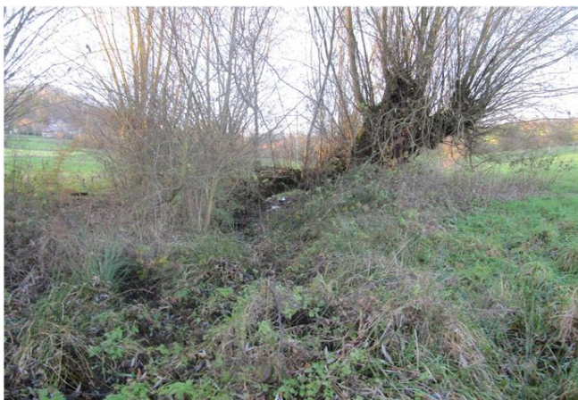
Foto gegen Fließrichtung
