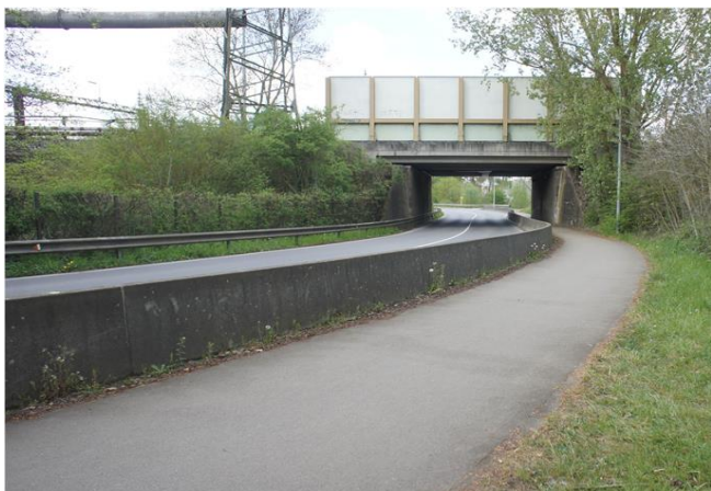
Foto gegen Fließrichtung
