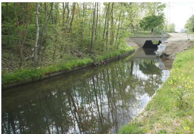
Foto gegen Fließrichtung
