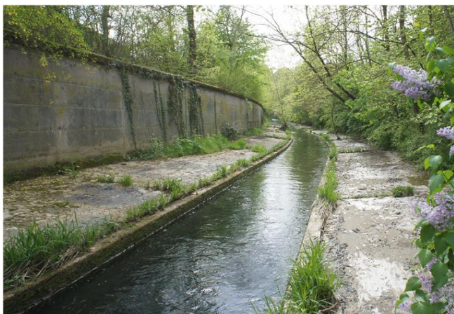
Foto gegen Fließrichtung
