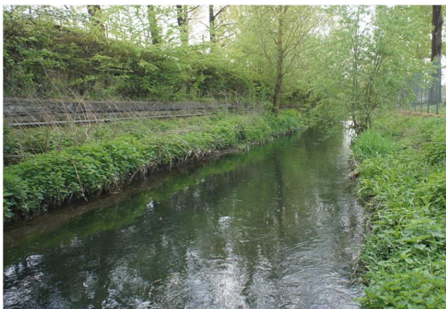
Foto gegen Fließrichtung
