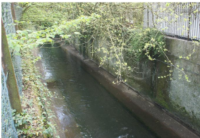
Foto gegen Fließrichtung
