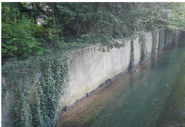
Foto gegen Fließrichtung
