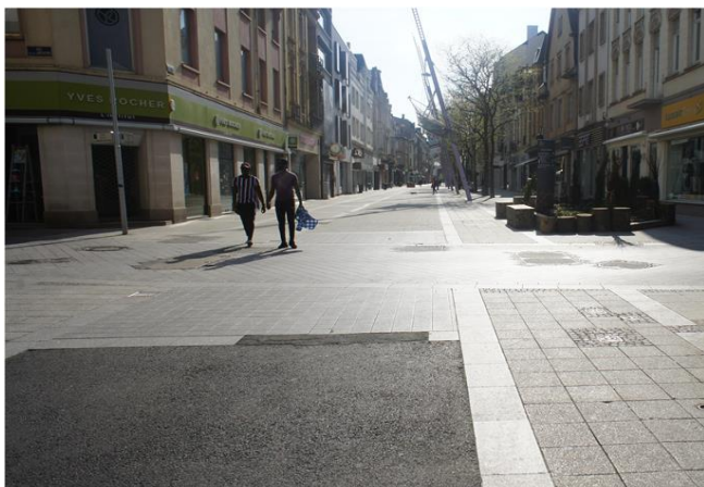
Foto gegen Fließrichtung
