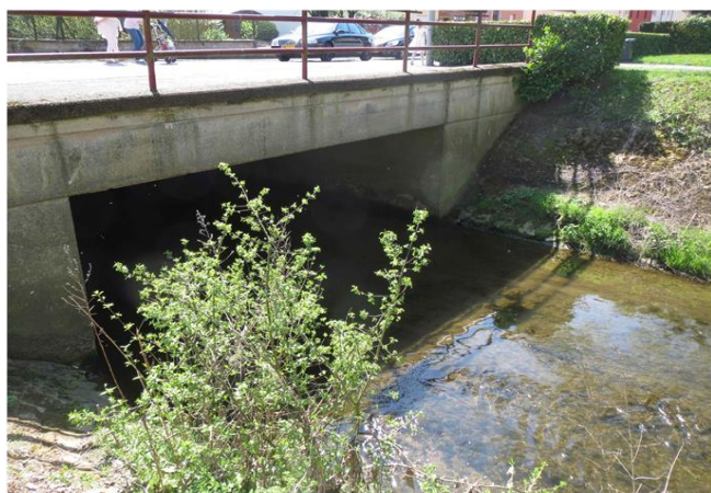
Foto gegen Fließrichtung
