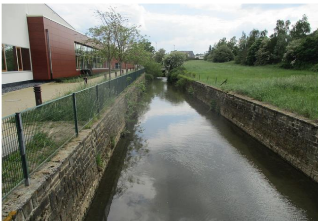
Foto gegen Fließrichtung
