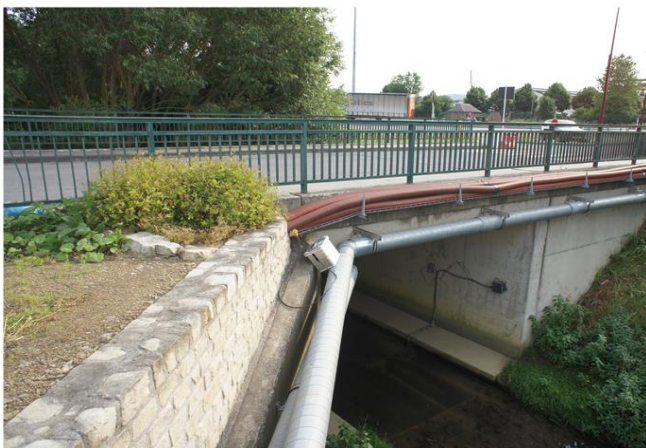
Foto gegen Fließrichtung
