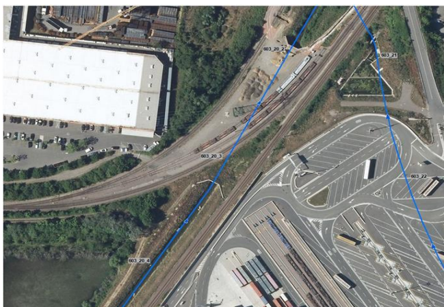
Foto gegen Fließrichtung
