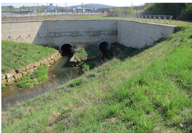
Foto gegen Fließrichtung
