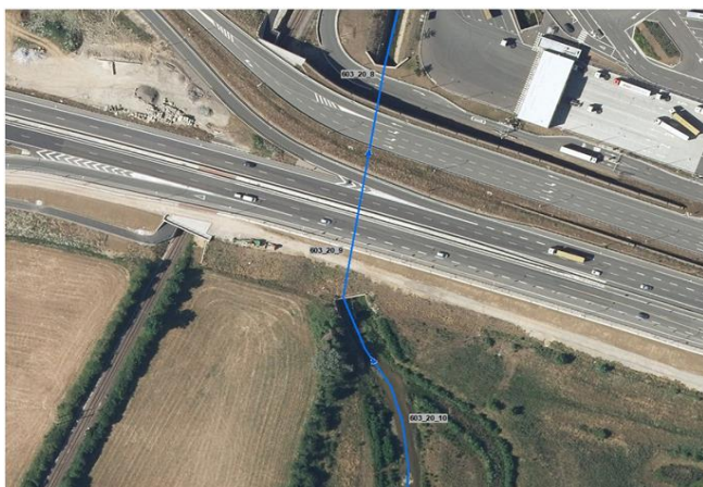
Foto gegen Fließrichtung
