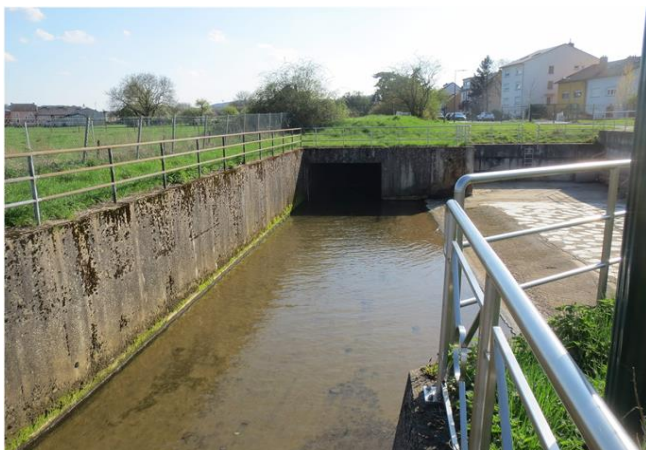
Foto gegen Fließrichtung
